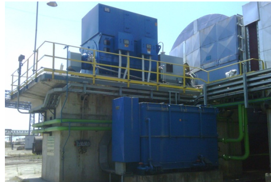
Aplicação típica de motor de indução trifásico de média tensão
