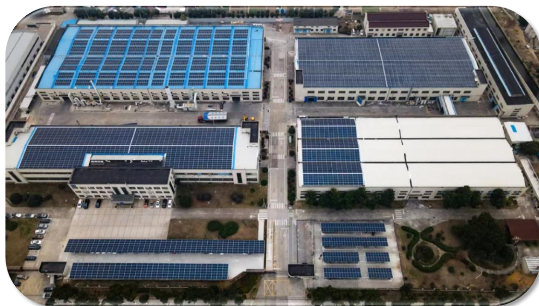
Painéis solares instalados sob os telhados da WCZ
