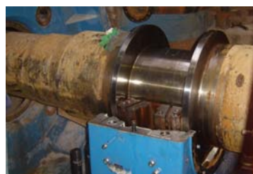
Figura 27: Corrosão no eixo
