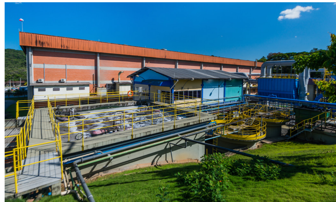
ETE - Estação de Tratamento de Efluentes
