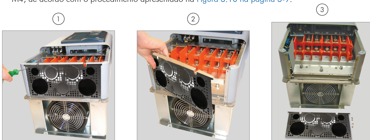
Figura 3.10 - Remoção da placa de passagem de cabos
