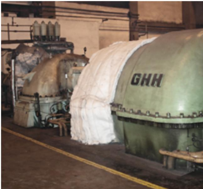
Recuperación de la cara de unión: Pérdidas de vapor, gas y líquidos en la cara de unión pueden provocar accidentes o pérdidas de rendimiento, además de perjudicar el medio ambiente. No siendo posible la retirada del equipo, para envío a la fábrica, utilizamos una técnica de recuperación de la cara de unión, en campo, con aplicaciones de materiales. Eliminamos las pérdidas, dejando el equipo en condiciones normales y sin riesgos durante la operación.
