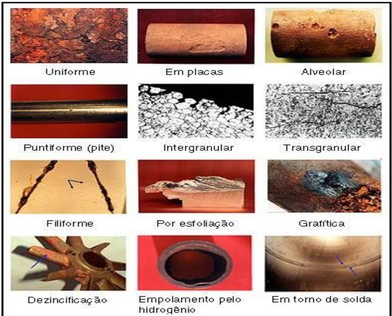
Figura 2: Formas de corrosão
