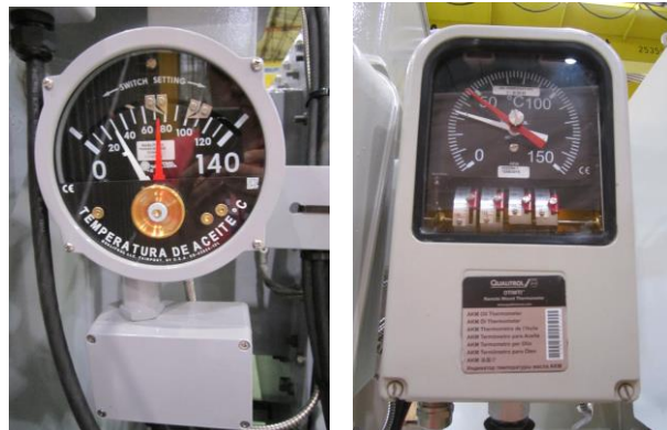
Figura 07 - Termômetros com bulbo com capilar e contatos tipo microswitch
