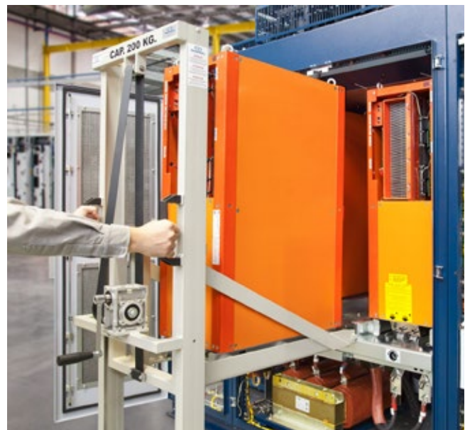
Procedimento de troca rápida dos braços de potência
