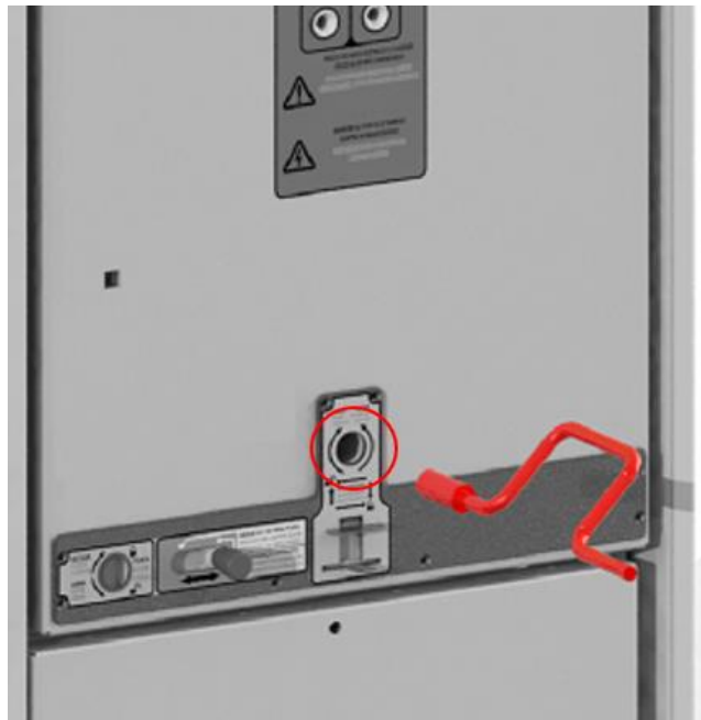
Figura 7.6: Acesso da alavanca de manobra de inserção/extração do disjuntor liberado.
