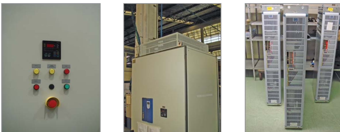
Figura 28 - Vista frontal com controlador de temperatura, detalhe do teto ventilado e frontal do book
