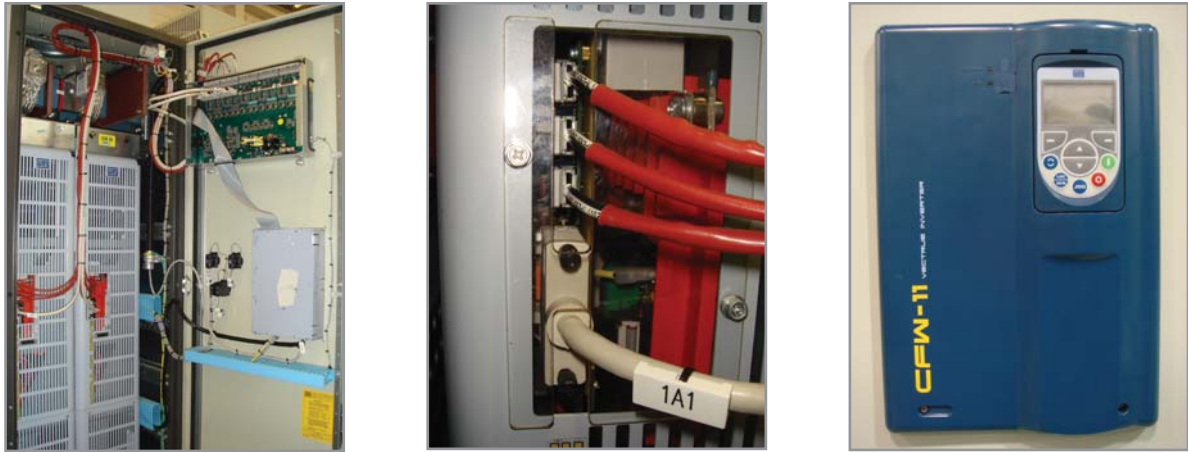
Figura 25 - Vista interna do painel, detalhe dos cabos de controle e frontal do CFW-11
