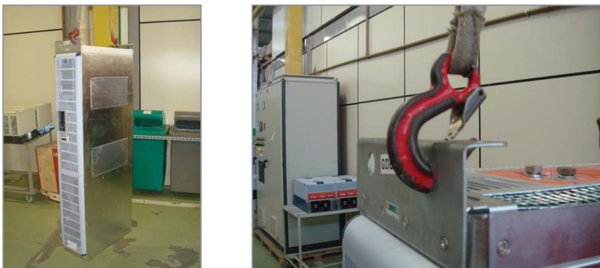
Figura 20 - Operação de retirada do book por içamento
