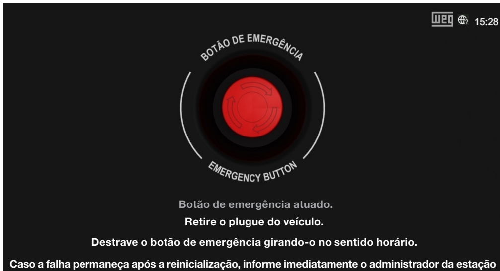
Figura 5.1: Tela sinalizando que o botão de emergência foi acionado
