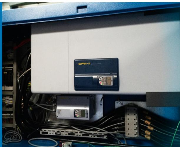
El cliente confió a WEG el suministro de una solución completa — incluyendo convertidores de frecuencia y motores — para una instalación de aire comprimido operando con compresores entre 200 kW y 400 kW. El proyecto exigía una solución personalizada para garantizar confiabilidad, eficiencia y adaptabilidad a las demandas específicas de la aplicación.
