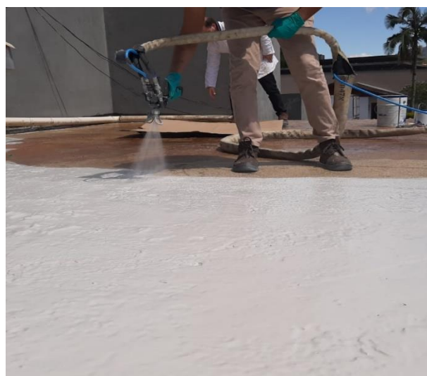
Figura 56 - Aplicação para impermeabilização de laje de concreto Fonte: O autor (2020)
