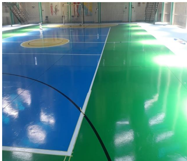
Figura 34 - Aplicação W-POXI DFA 301 em quadra poliesportiva, em duas demãos. Fonte: O autor (2020)
