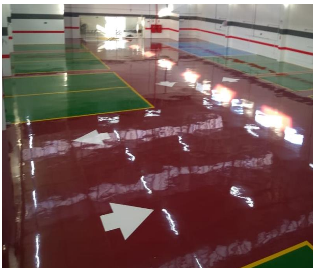
Figura 36 - Aplicação do epóxi autonivelante, W-POXI HBA 301
