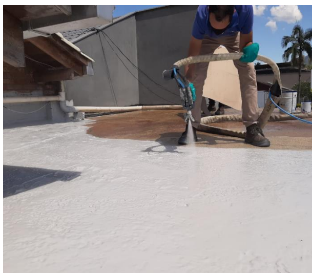
Figura 55 - Aplicação para impermeabilização de laje de concreto Fonte: O autor (2020)
