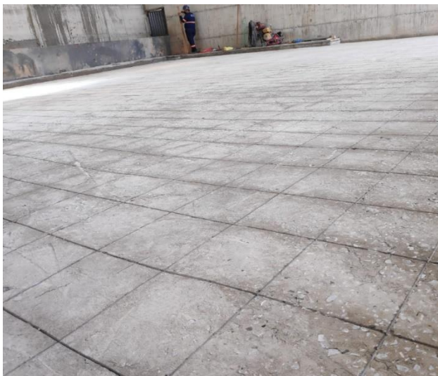
Figura 48 - Ancoragem para o CREETY NA Fonte: O autor (2020)
