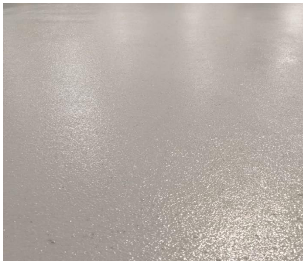
Figura 45 - Acabamento do produto antiderrapante Fonte: O autor (2020)
