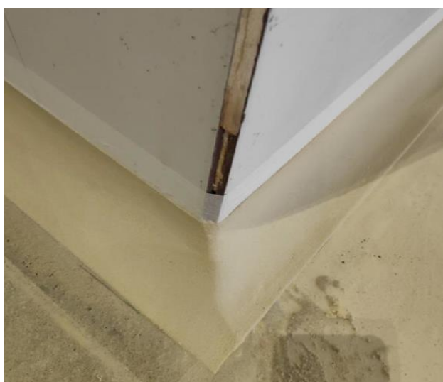
Figura 52 - Pintura de CREETY RP Fonte: O autor (2020)
