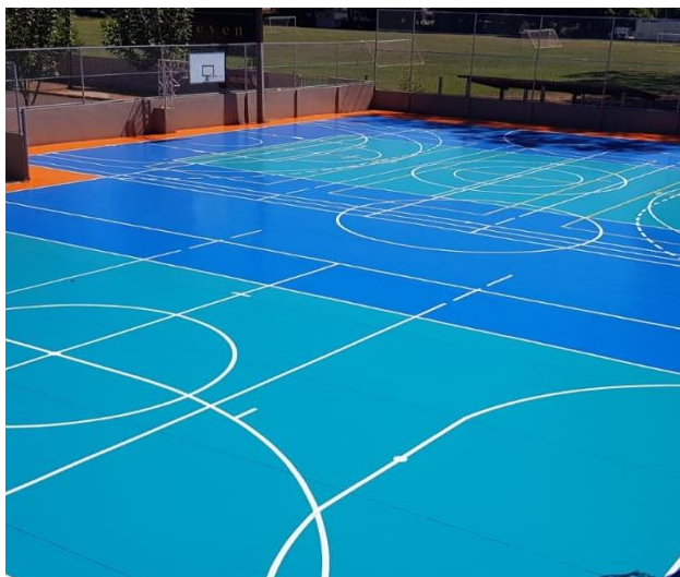
Figura 42 - Aplicação do acabamento W-THANE HBA 501 Fonte: Cortesia representante (2019)
