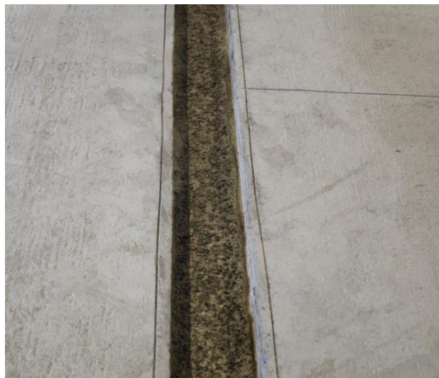
Figura 49 - Ancoragem para o CREETY NA Fonte: O autor (2020)
