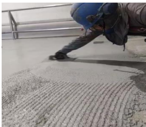
Figura 55 - Pintura de CREETY ES Fonte: O autor (2020)
