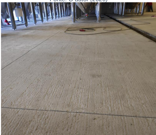
Figura 50 - Ancoragem para o CREETY AN Fonte: O autor (2020)
