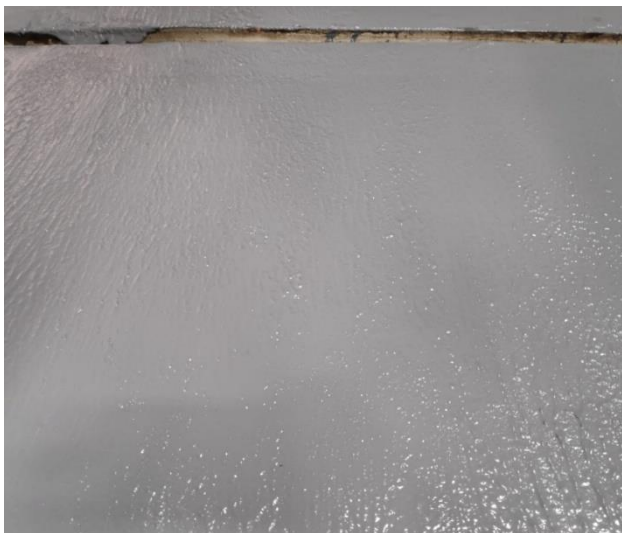
Figura 44 - Acabamento do produto antiderrapante Fonte: O autor (2020)
