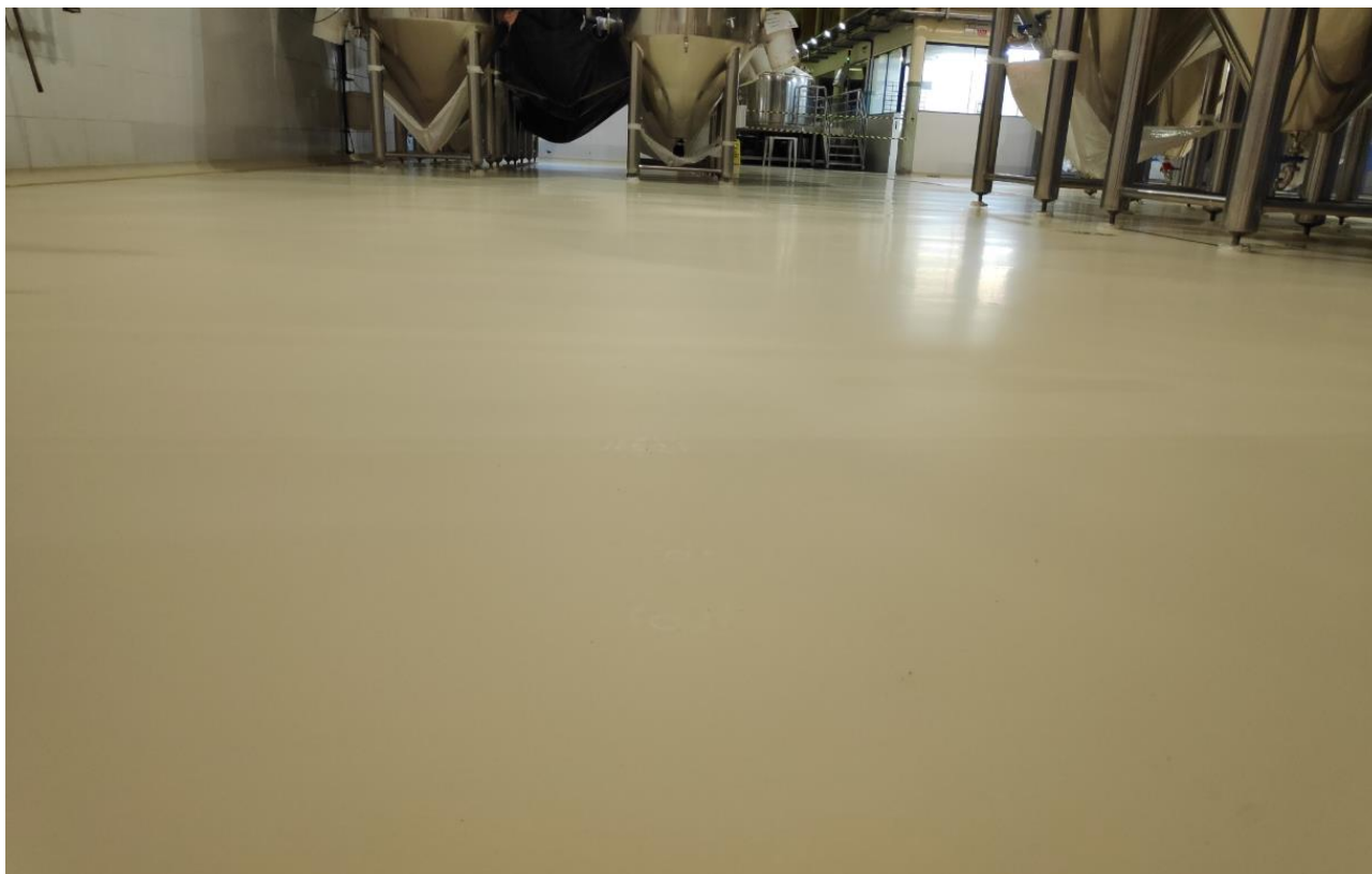
Figura 46 - Pintura do autonivelante uretano CREETY AN. Fonte: O autor (2020)
