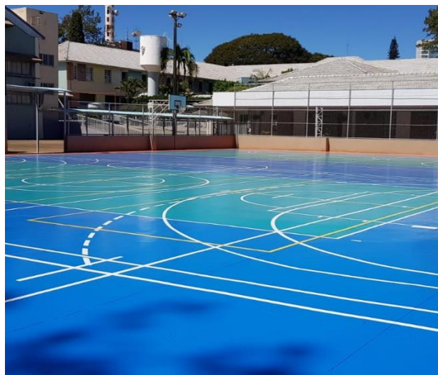
Figura 43 - Aplicação do acabamento W-THANE HBA 501 Fonte: Cortesia representante (2019)
