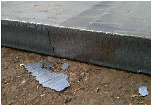
Figura 15: Carepa de laminação se despreendendo do aço
