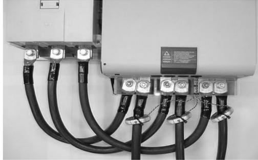
Figura 9.15 - TCs para adquisición de corriente externa
