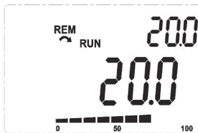
Figura 15.3: Ejemplo de la HMI en modo monitoreo para la utilización del regulador PID
