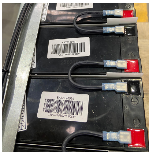
Figura 5.2: Exemplo de conexão entre polo positivo (vermelho) e negativo (preto) das baterias
