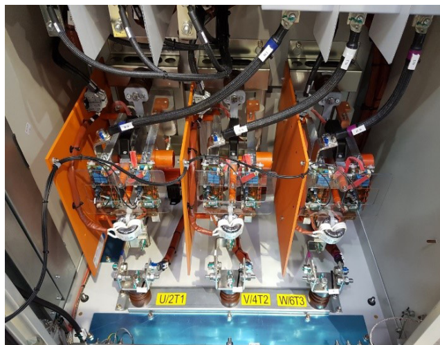
Figura 5.28: Inserção dos braços de potência – SSW7000C
