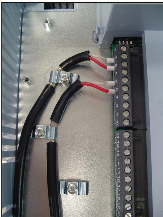
图3.19 - 控制线路的屏蔽接线实例
