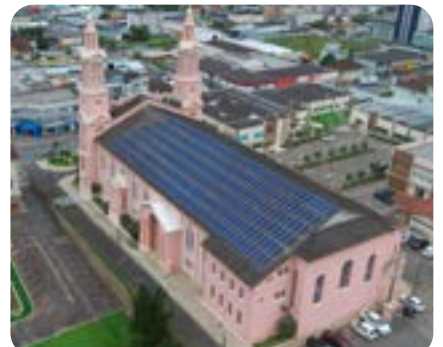
Generador fotovoltaico para entidades religiosas de 60 kWp - SC
