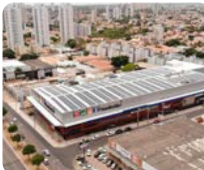
Generador fotovoltaico comercial de 492 kWp - RN
