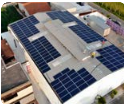
Generador fotovoltaico industrial de 56 kWp - RJ
