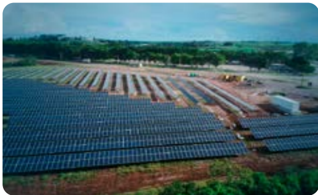
UFV RAÍZEN - 1.267,00 kWp
