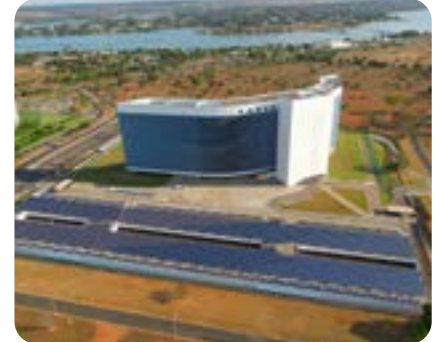
Generador fotovoltaico para el sector público de 304 kWp - DF
