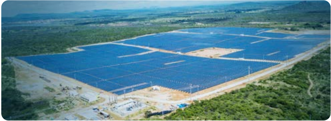
UFV ANGICO Y MALTA - 63.120,00 kWp
