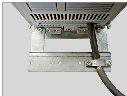
Figure 3.15 - Détail de la connexion du blindage de câbles du moteur avec l'accessoire PCSx-01 installé
