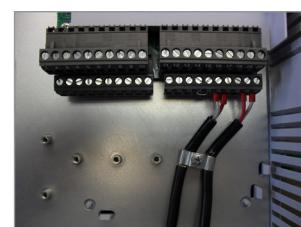
Abb. 3.7: (a) und (b) Anschluss der Kabelschirmung
