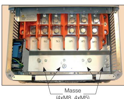
**R/L1, S/L2, T/L3:** Wechselstromversorgung
