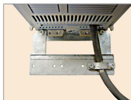
*Figure 3.4 : Connexion du blindage du câble moteur avec l'accessoire PCSx-01*
