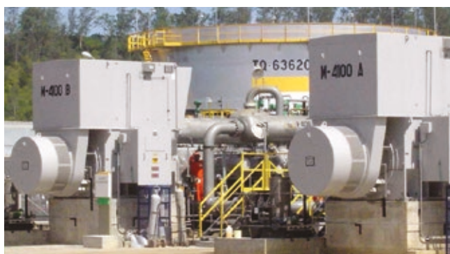
Motores Síncronos SEF900 (Ex-p), 3.600 kW, 13.200 V Aplicação: Compressores recíprocos (petroquímica)
