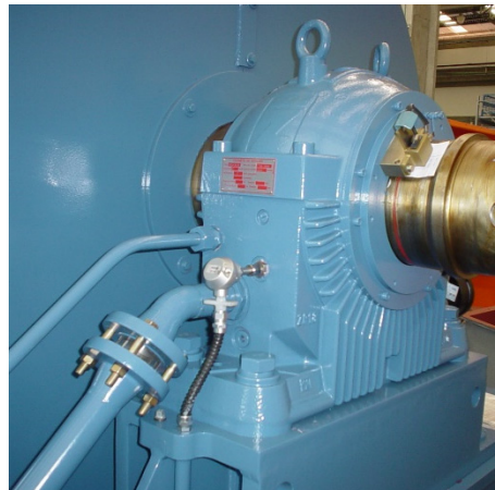
Figura 4.7: Mancal de bucha com circulação externa de óleo.
