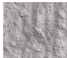
CSP 9 – Escarificación (fresa) pesada 5435,6 µm*
