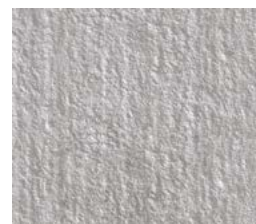
CSP 4 – Escarificación (fresa) leve 1270 µm*
