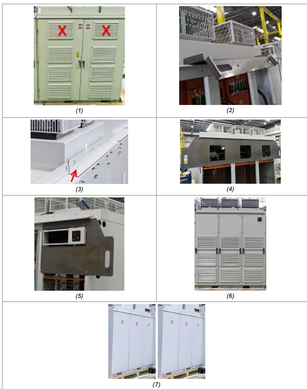
Ábra 6.4: Eljárás a légszállító erősítések eltávolításához az MVW3000-ről
