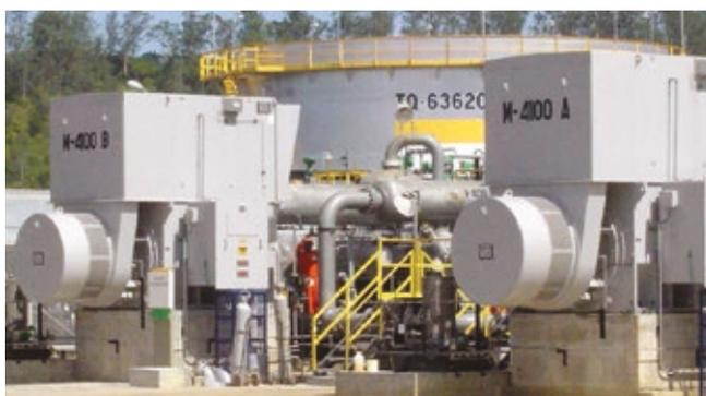
Motores sincrónicos SEF900 (Ex-p), 3.600 kW, 13.200 V
