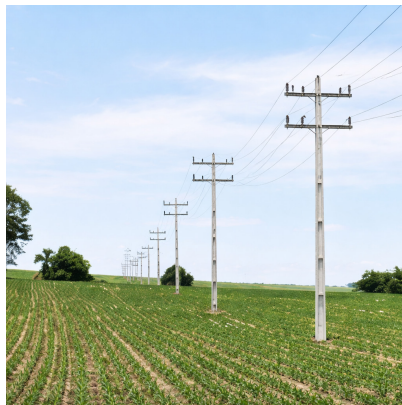
Figura 6.1: Rede de distribuição rural (monofásica) até 37,5 kVA
