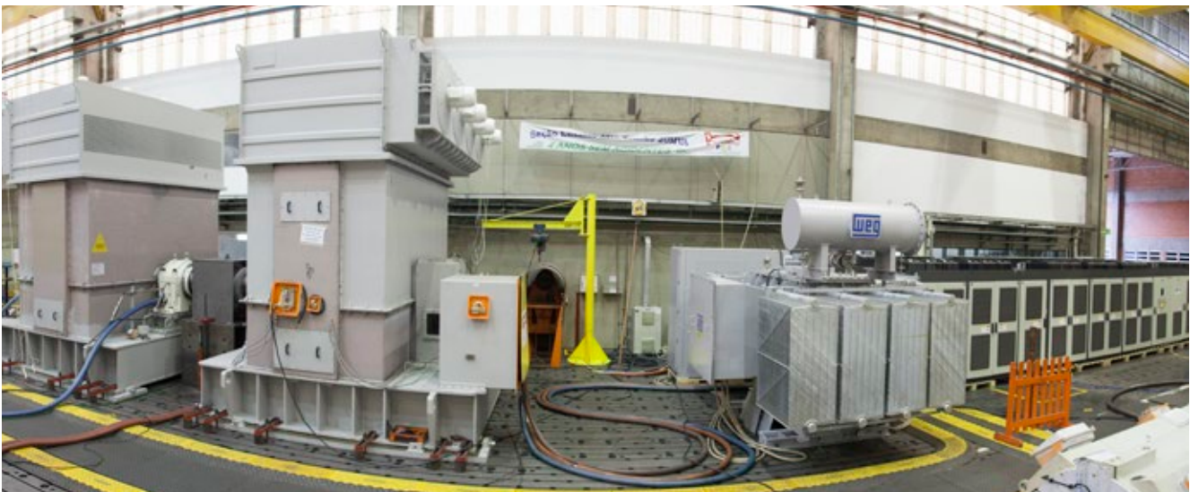
Prueba combinada (Conjunto de Maniobra de Entrada MT + Transformador Desfasador + Convertidor MT + Motor MT)
