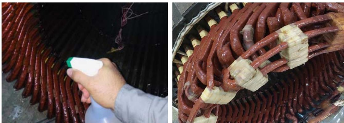
Figura 12: Amostra de estator de alta tensão - Contaminado (Fonte: WEG)
