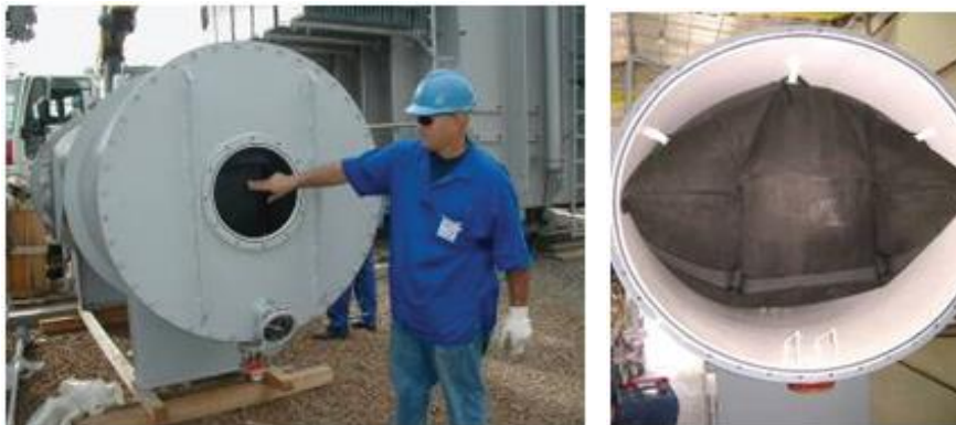
Figura 15 - Teste estanqueidade na bolsa de borracha
