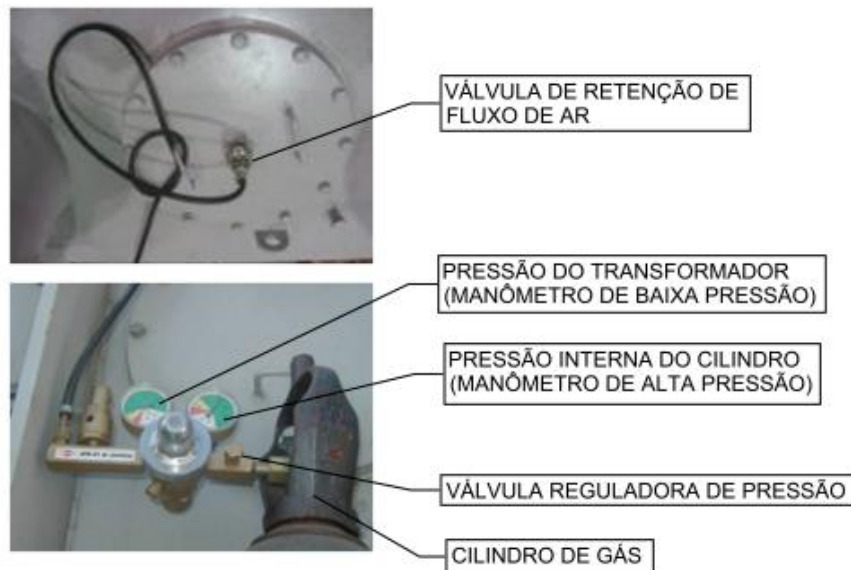
Figura 04 - Ligação do sistema de pressurização automático
