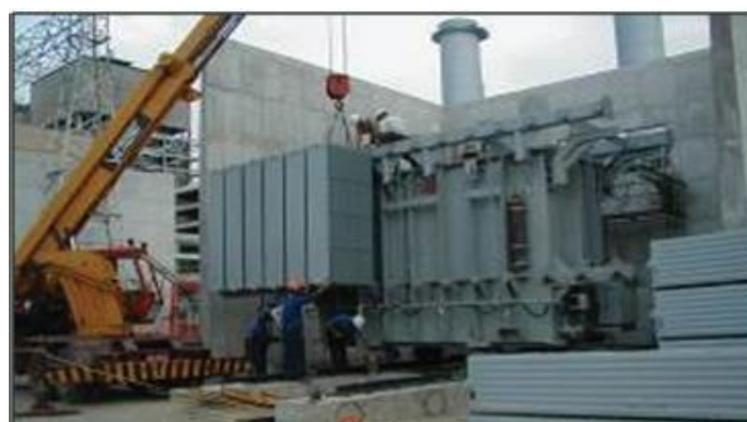
Figura 19 - Desmontagem do radiador
