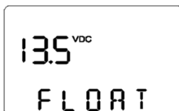
Figura 5.8: Configuração da tensão de flutuação das baterias do Studio
