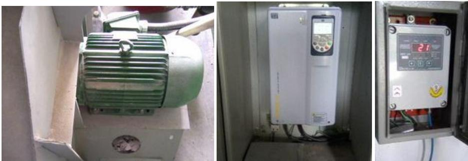
Fotos do Motor W22 Premium / Inversor CFW 11 / Transmissor de Pressão
