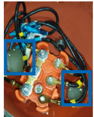
Figura 15 - Detalhe do nível de óleo
