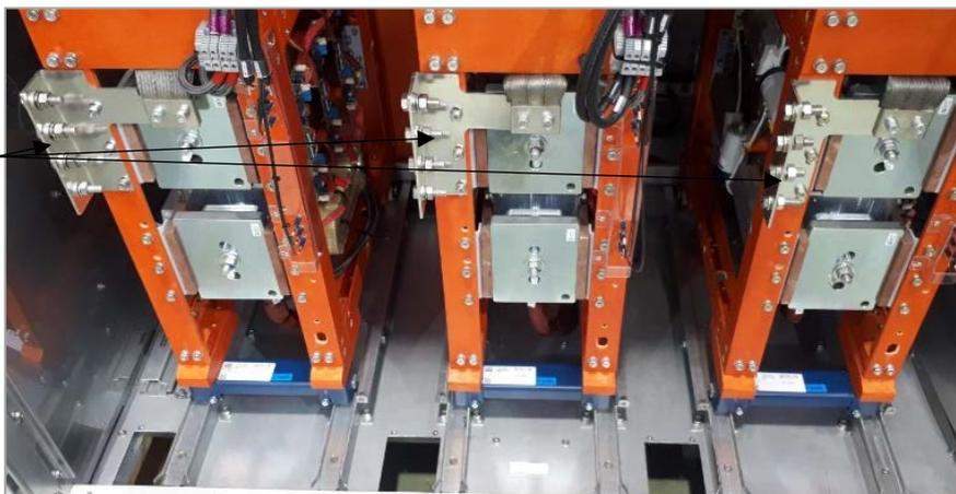
**Figura 5.30 (c):** Conexiones de salida para el motor – SSW7000D
