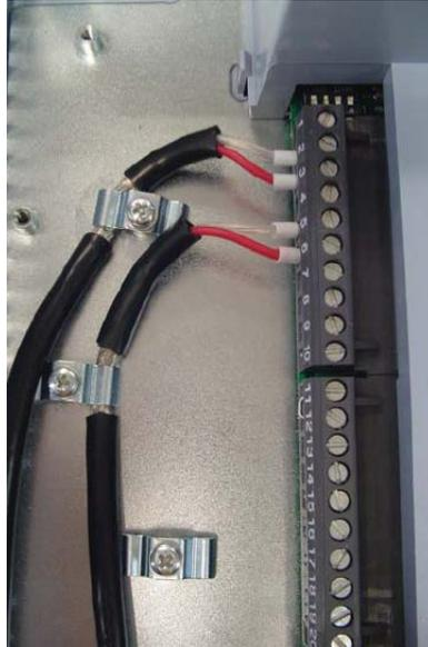
**Figura 5.39:** Ejemplo de conexión del blindaje de los cables de señal
