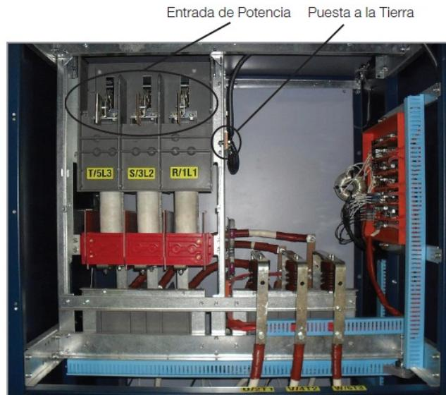
Figura 5.29 (a): Lado trasero del armario. Conexiones de entrada de potencia y de puesta a la tierra -SSW7000A- IP41
