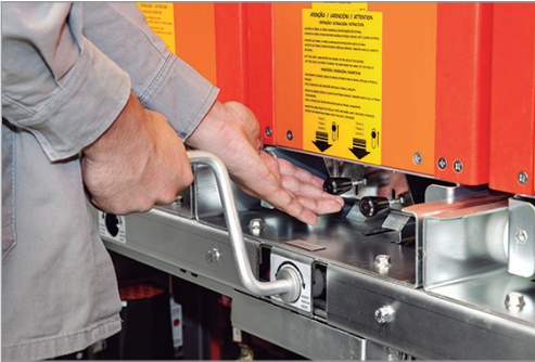
Şekil 10.7: Kol yerleştirme aşamalarının ayrıntıları
