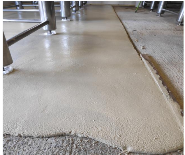
Figura 48 - Pintura do reparador uretano Fonte: O autor (2020)
