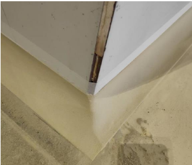
Figura 47 - Pintura de rodapé Fonte: O autor (2020)
