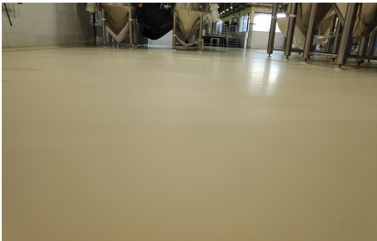
Figura 46 - Pintura do autonivelante uretano W-POLI ANA 455 Fonte: O autor (2020)
