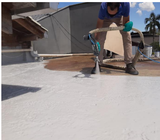
Figura 63 e 64 - Aplicação para impermeabilização de laje de concreto Fonte: O autor (2020)
