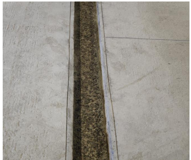
Figura 50 - Ancoragem para o W-POLI ANA 455 Fonte: O autor (2020)
