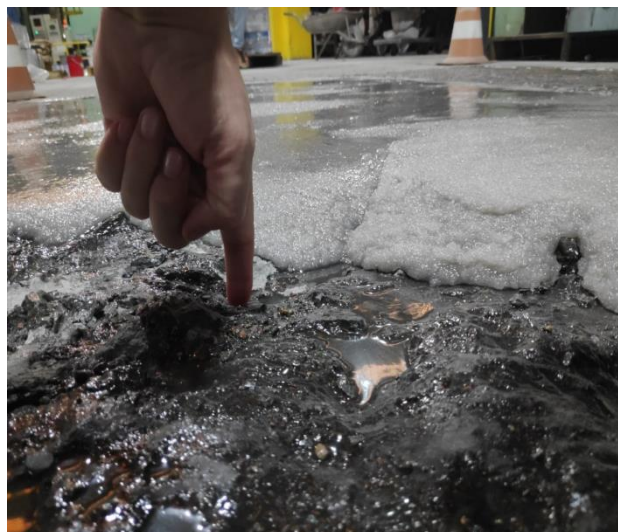
Figura 30 - Aplicação do acabamento sobre W-POXI PRP 301 Fonte: O autor (2020)
