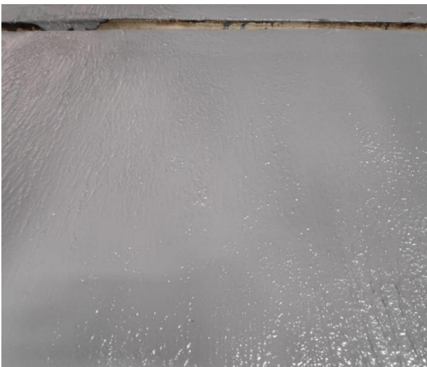
Figura 44 e 45 - Acabamento do produto antiderrapante Fonte: O autor (2020)
