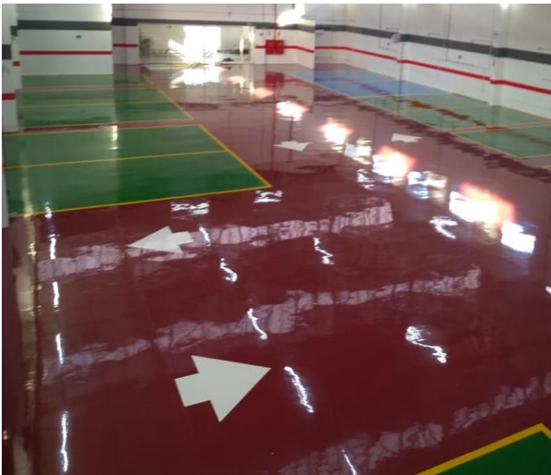
Figuras 36 e 37 - Aplicação do epóxi autonivelante, W-POLI HBA 301 Fonte: Cortesia representante (2019)
