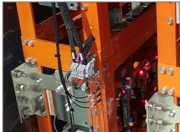
Figure 5.27 (d): Détails des étapes d'installation des câbles sur les bras de puissance SSW7000D
