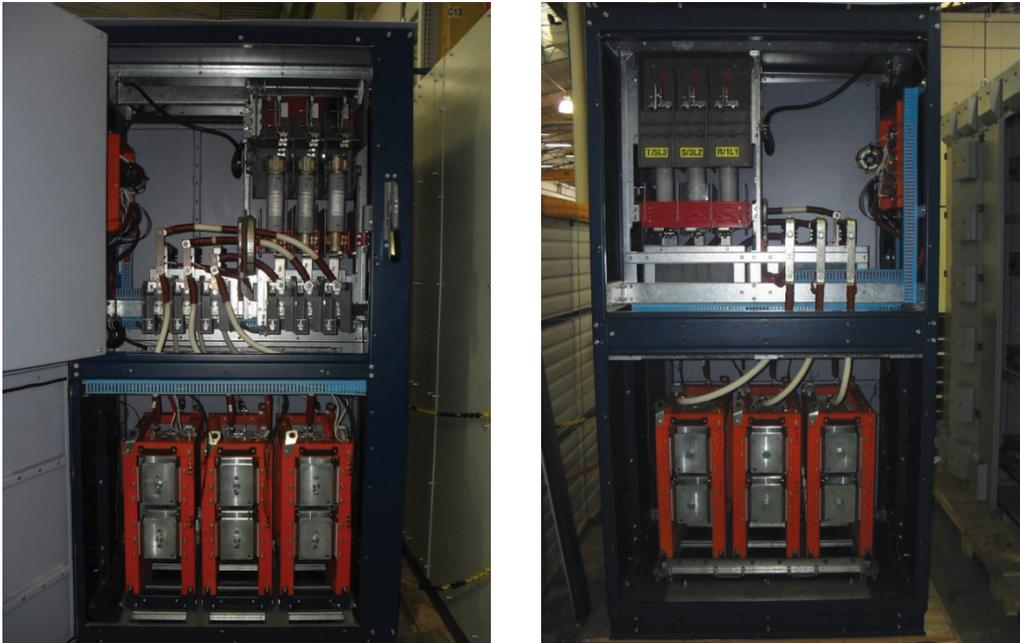
Figure 5.8: Compartiment de moyenne tension (recto et verso) – IP41 SSW7000A
