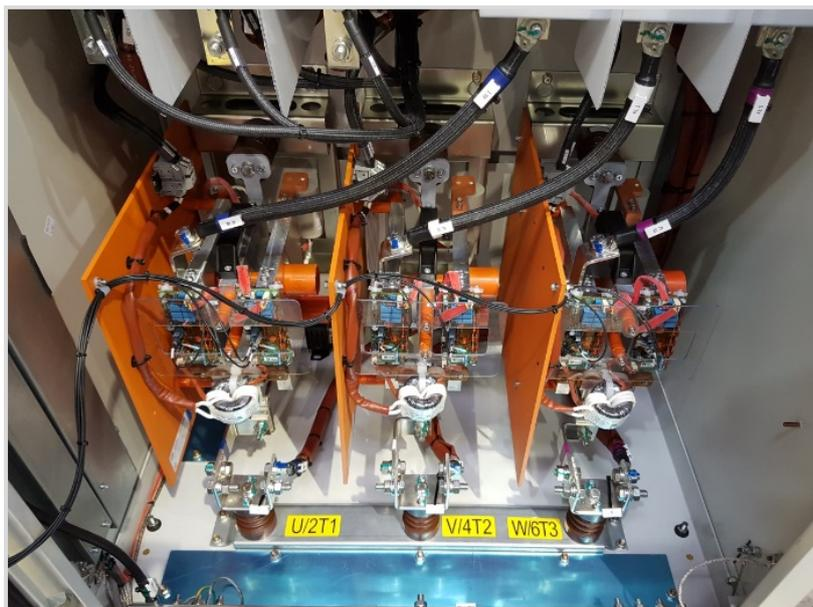
Figure 5.18: Insertion des bras de puissance – SSW7000C IP54.
