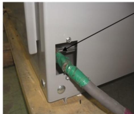
Figure 5.29 (b) : Raccordements d'entrée de puissance et de terre – Nema 12
