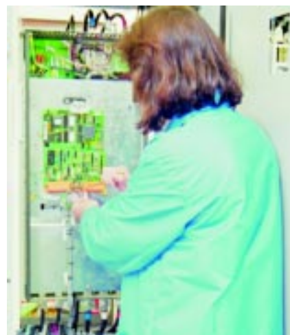
Instalação de inversor exige cuidados
