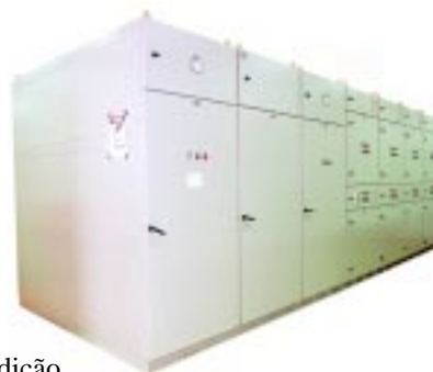
Painéis de comando Weg controlam os equipamentos da usina na Terranova Brasil
