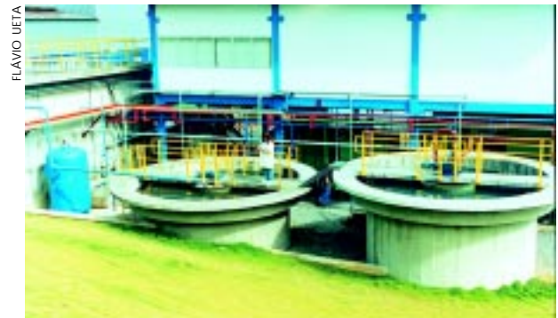
Capacidade de tratamento é de 7,5 m³/hora
