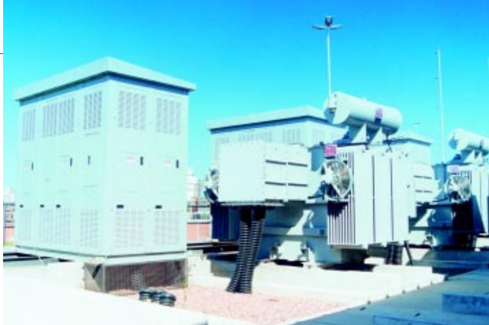
Marca Weg também está presente nos transformadores
