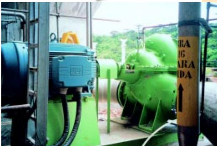
Na foto de cima, estação do sistema supervisorío com CLP Weg/Bosch; à direita, motor CA de 300 cv - bomba de mistura
