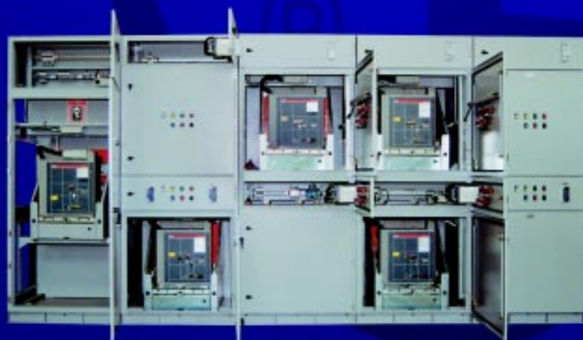
Cubículo de Média Tensão
