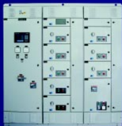
Centro de Controle de Motores - CCM, convencional ou inteligente (DeviceNet, Profibus, Modbus)
