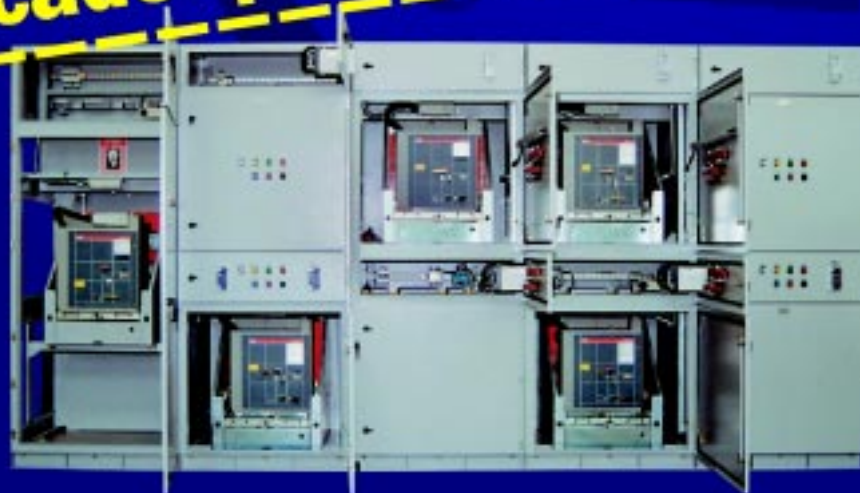
Cubículo de Média Tensão
