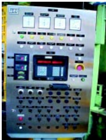
Novo painel de operação WEG
