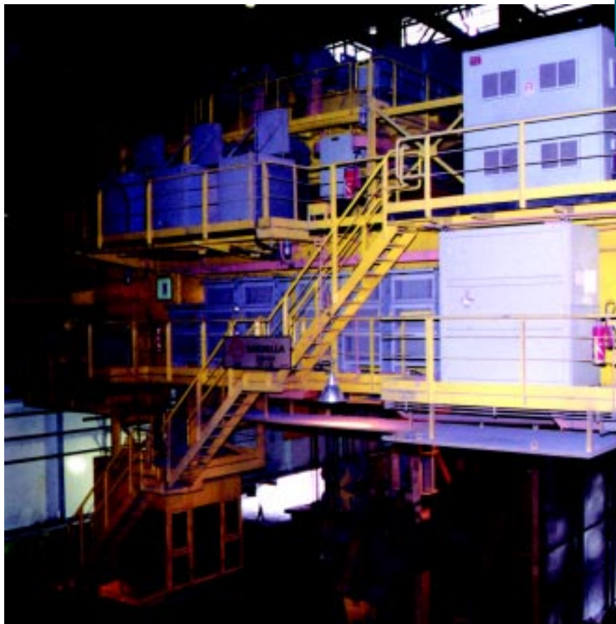
Ponte-rolante tem capacidade total de elevação de 300 toneladas
