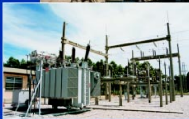
Subestações convencionais e móveis, em regime turn-key até 150 MVA - Classe 230 kV
