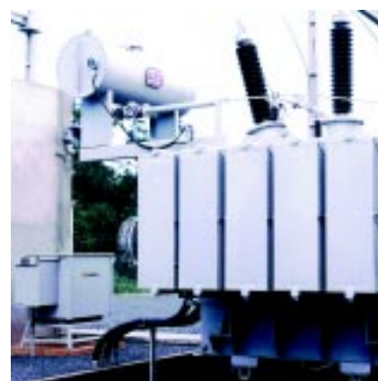
Fig. 1 – Detalhe de Subestação AT
