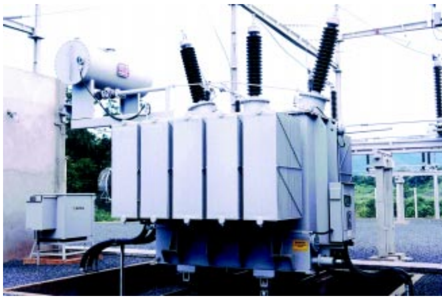
Um dos transformadores da subestação
