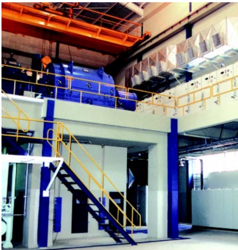
Equipamentos WEG na Cerradinho
