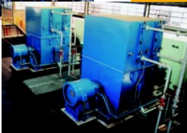
Dois geradores de 15 MW, para dobrar a produção
