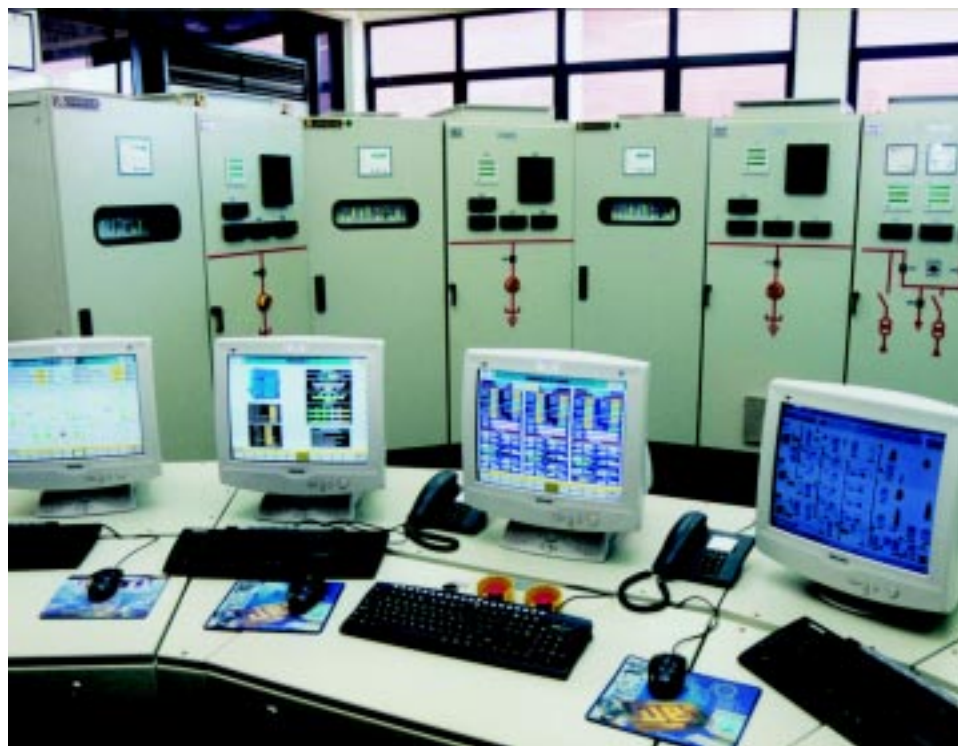
Monitoramento pode ser feito via internet
