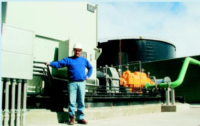
▶ Daniel Lucas Coniglio ao lado de um motor MGF630B de 4.850 HP, instalado em uma bomba com capacidade para substituir outras quatro que têm mais de 40 anos de uso; à direita, a bomba e um reservatório gigante de água proveniente dos poços petrolíferos, na jazida Vizcacheras, região semi-desértica na província de Mendoza
