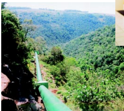
► A esquerda, Gnann e Norberto; nas outras fotos, detalhes da PCH Cascata das Andorinhas, mostrando os equipamentos WEG instalados
