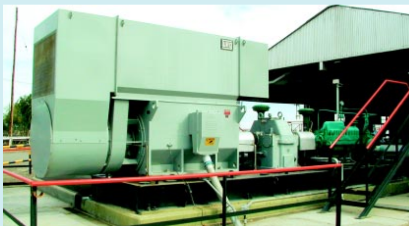
▶ Motor MGF560A de 3.500 HP aciona uma bomba de injeção de água a alta pressão
