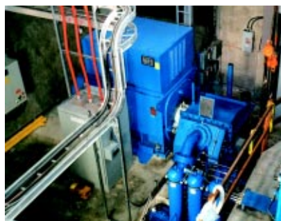
Gerador para a Epcor-Miller Creek
